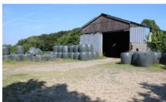
Figure 81 : Ancien bâtiment d'exploitation agricole
