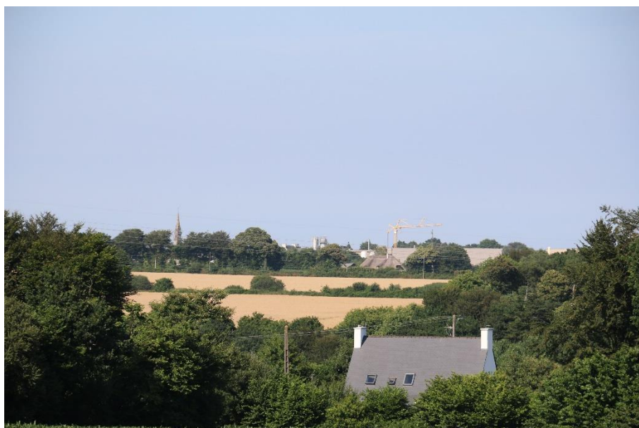
Figure 74 : Perception du clocher de l'église de Plouédern depuis le site d'étude (zoom)
