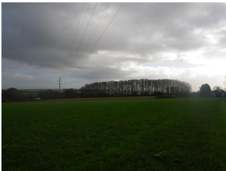
Figure 89 : Lignes à haute tension sur le site projet
