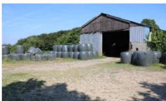
Figure 81 : Ancien bâtiment d'exploitation agricole
